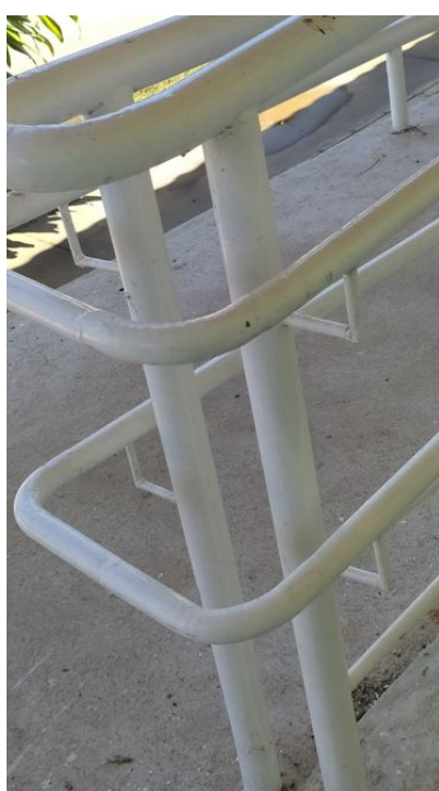
Corrimão (parte externa do prédio novo) em altura inadequada
