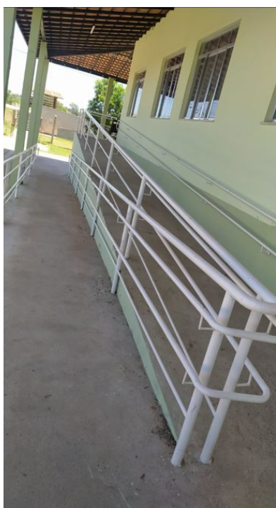
Corrimão (parte externa do prédio novo) em altura inadequada
